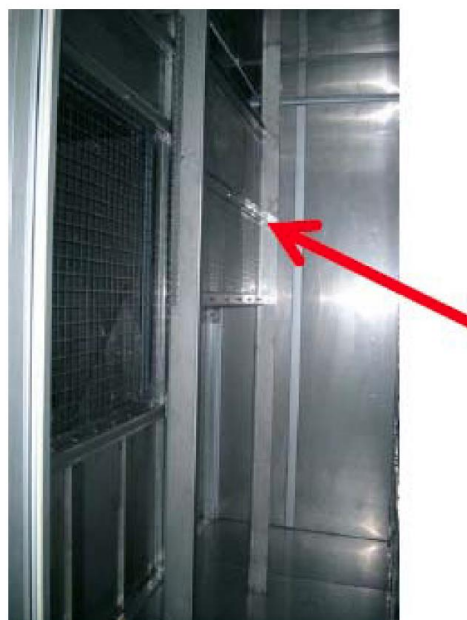
Figura 2 – Perfil de escoamento de um ventilador centrífugo, como tal, há necessidade de montar um deflector na descarga
